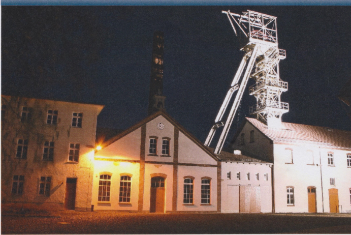
Links: Schachtgebäude und Förder-turm des Silberbergwerks „REICHE ZECH“
